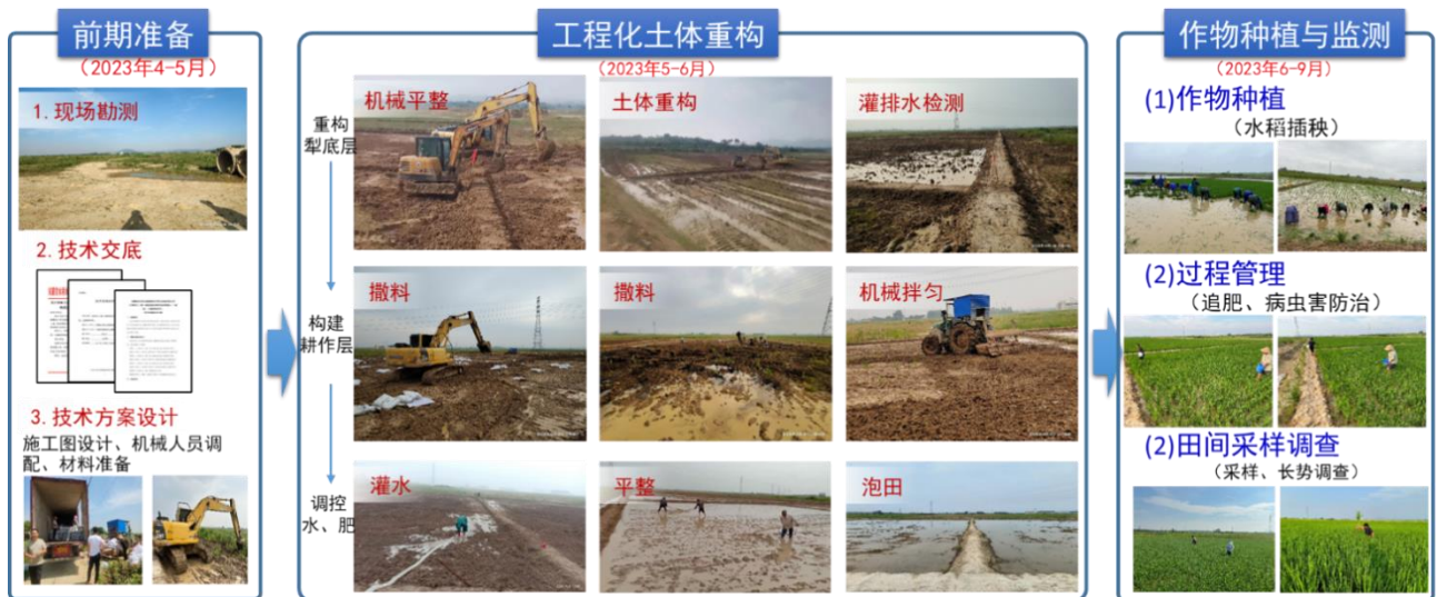
图10 土体重构全流程场景及项目进度图
