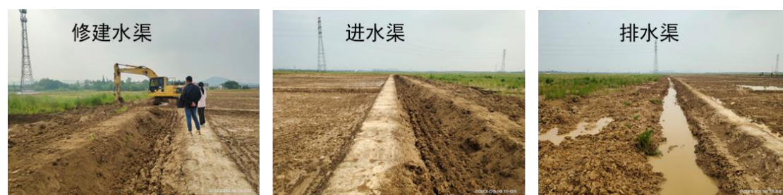
图 7 试验前修建进、排水设施现场图
