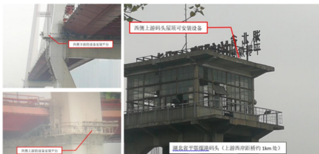
图 16.白沙洲大桥实景图
