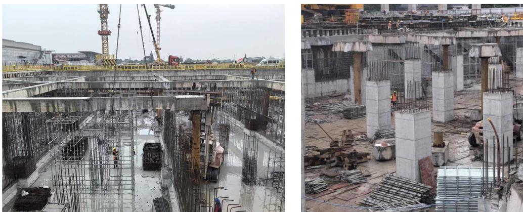
6.6.3 钢管混凝土立柱拆除时，宜采用等离子切割设备首先割除钢管，再用绳锯或盘锯切割内部混凝土。
