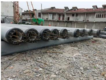
④ 安装锚固螺栓和灌芯钢筋笼
