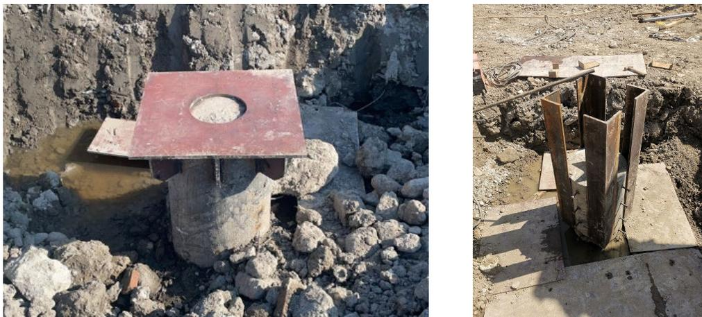
①连接钢板+锚筋施工时立柱周边超挖 ②连接角钢施工时立柱周边超挖
