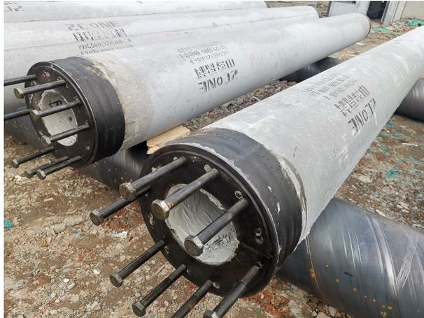
图 6-3-3 管桩端板张拉孔安装锚固螺栓实景照片
