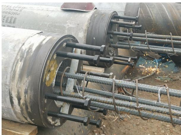
图 6-3-4 灌芯钢筋笼采取扁钢固定实景照片
