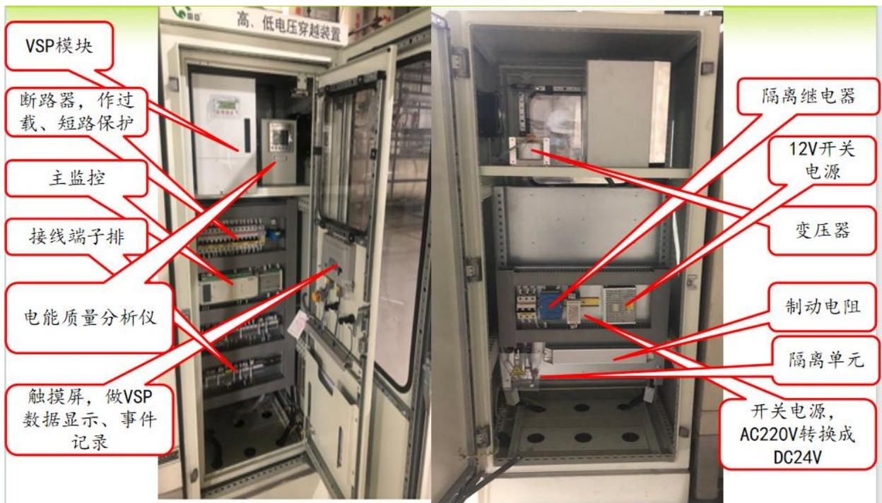
图 4 高低电压穿越装置内部配置
