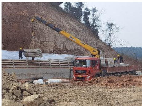
a) 起重机械吊装
