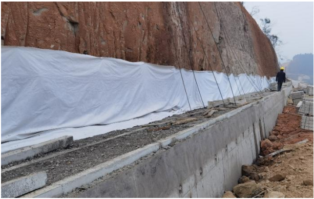
图 22 反滤土工布施工
