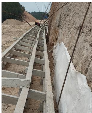
图 25 预制构件安装示例
