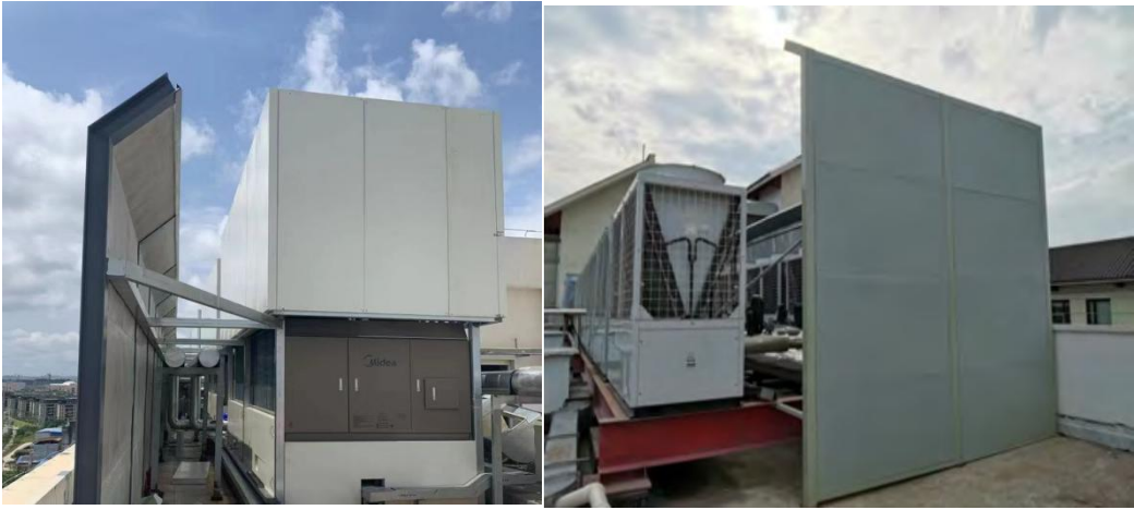
风冷热泵机组噪声控制工程案例（隔声屏障）
