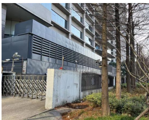
风冷热泵机组噪声控制工程案例（进排风消声与隔声罩）
