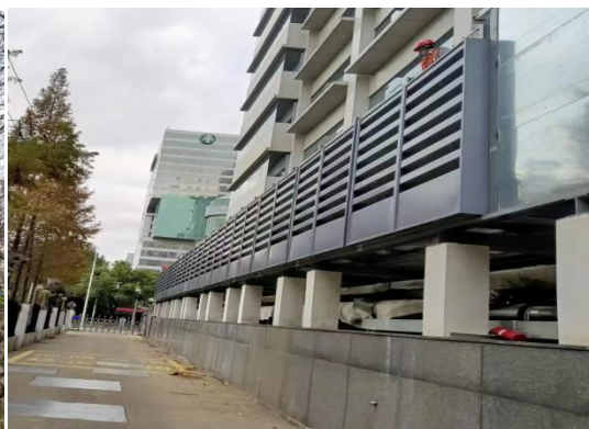
风冷热泵机组噪声控制工程案例（进排风消声与隔声罩）
