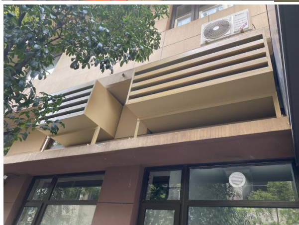
风冷热泵机组噪声控制工程案例（进排风消声与隔声罩）
