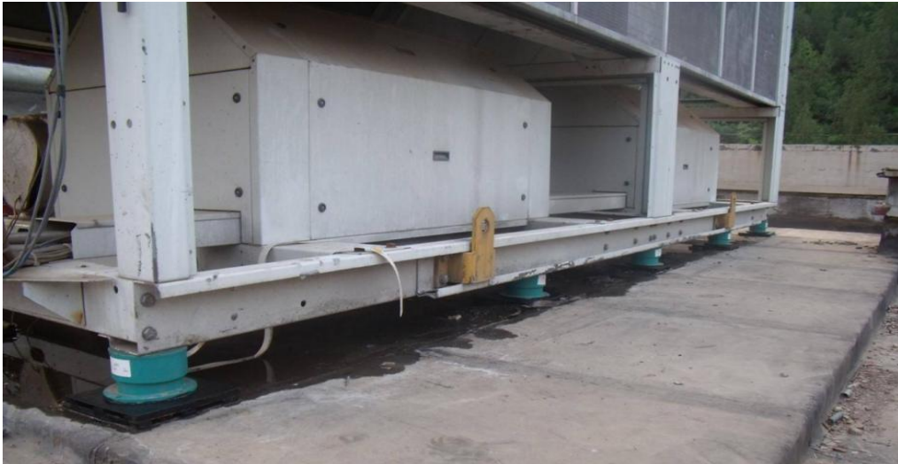
风冷热泵机组噪声控制工程案例（基础及管路隔振）
