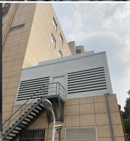
风冷热泵机组噪声控制工程案例（进排风消声与隔声罩）
