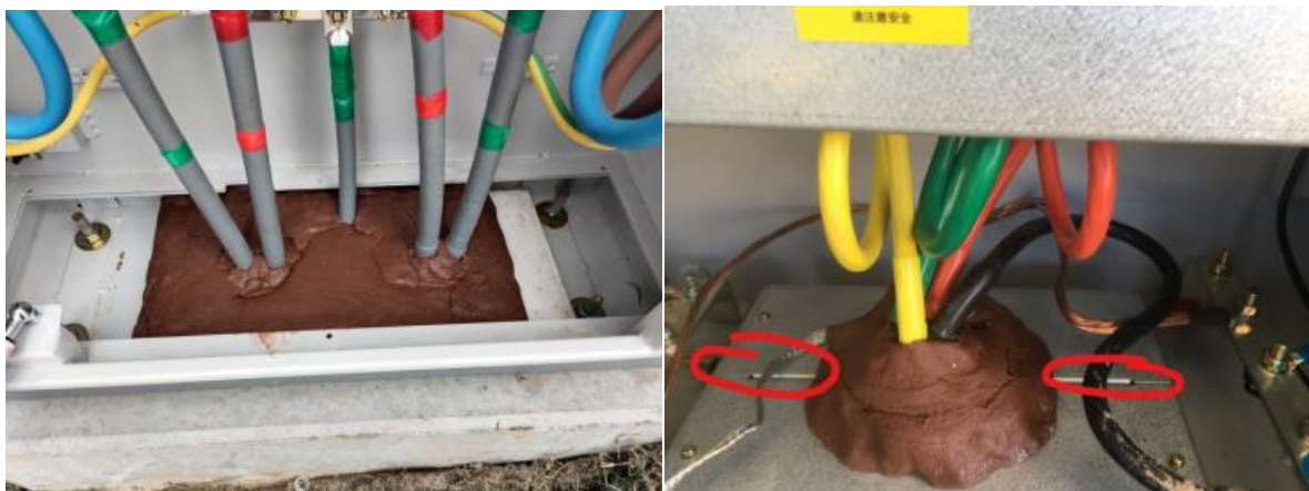
图4 完全封堵示意图（左）和错误封堵图（右）
