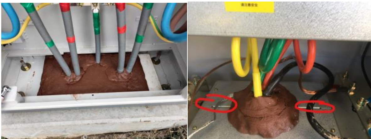
图4 完全封堵示意图（左）和错误封堵图（右）
