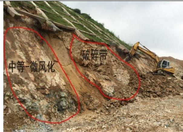
东侧边坡坡脚沿断层面发生滑塌
