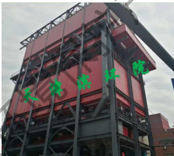
图 1 石横特钢公司脱硫脱硝一体化装置图
