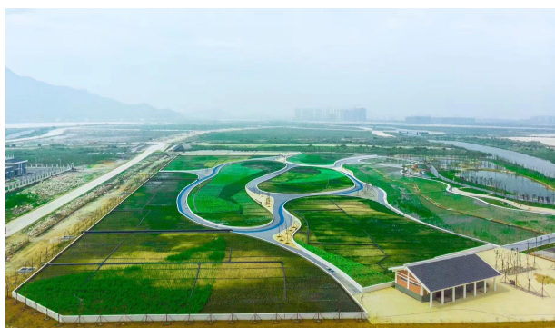
附图 7 污水处理厂尾水处理工程实拍图
