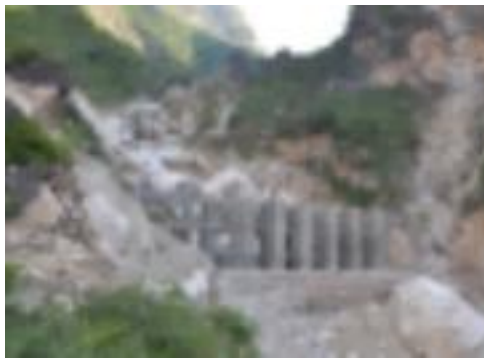
(c) 鲁甸龙头山镇泥石流沟桩梁组合
