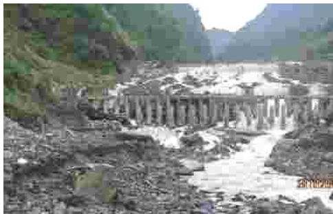
(c) 鲁甸龙头山镇泥石流沟桩梁组合
