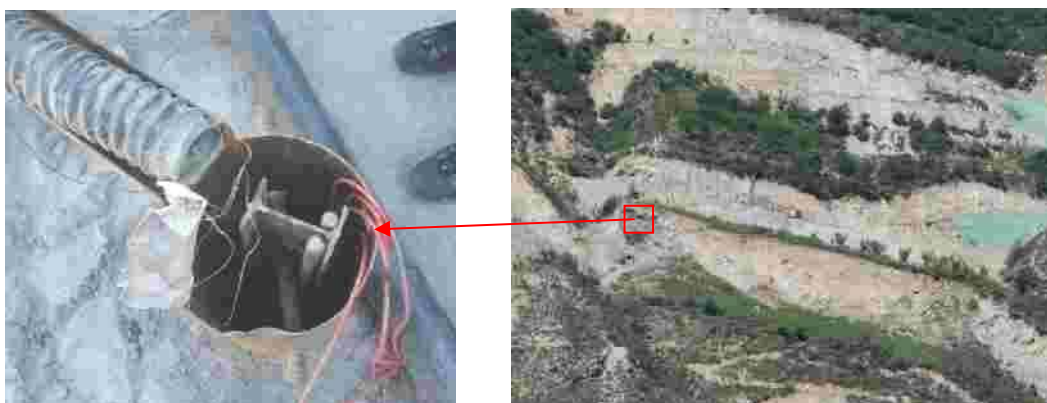
图2.8 梯子槽滑坡小口径组合桩现场试验性施工
