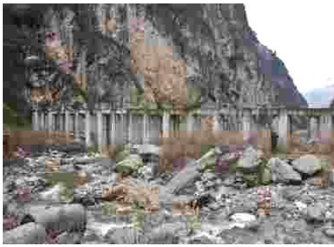
(d) 汶川棋盘沟桩梁组合结构
