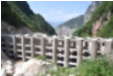
(f) 舟曲泥石流桩梁组合结构
