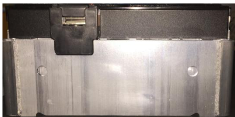
图 54 侧板折弯对接焊缝
