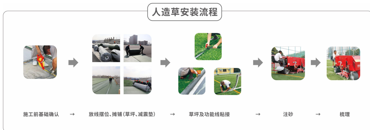
图7 （免填充型人造草施工流程）
