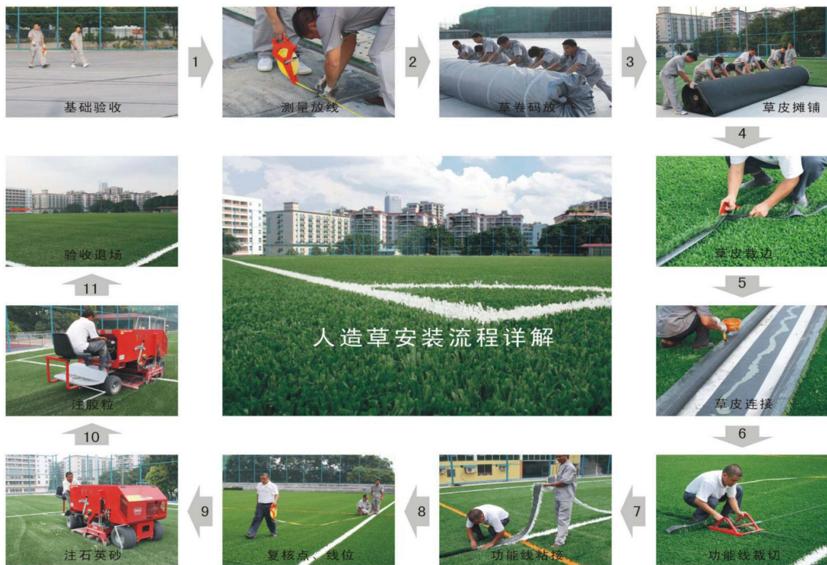
图6 （填充型人造草施工流程）
