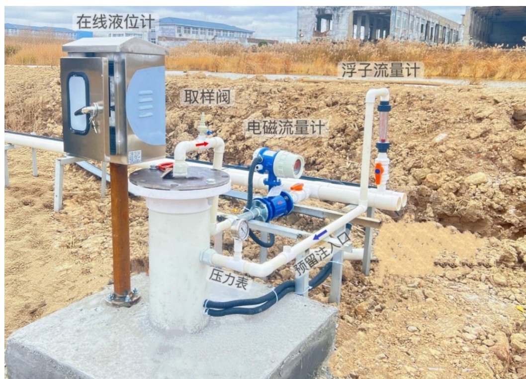
图 6 抽注一体的功能井结构示意图
