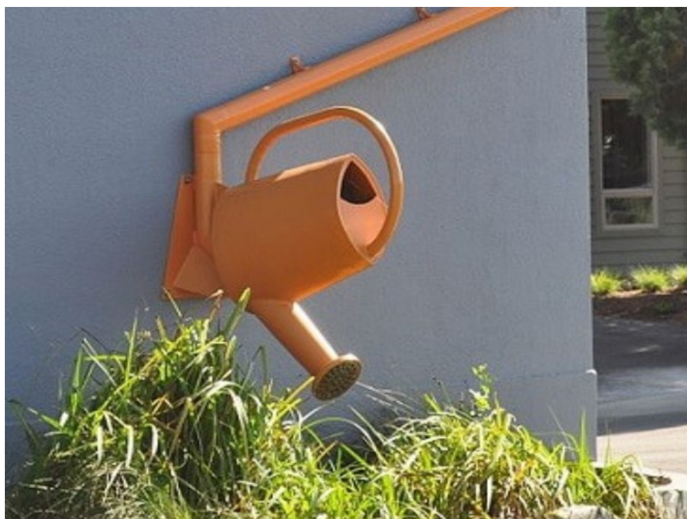
图 20 雨落管断接+雨水链改造
