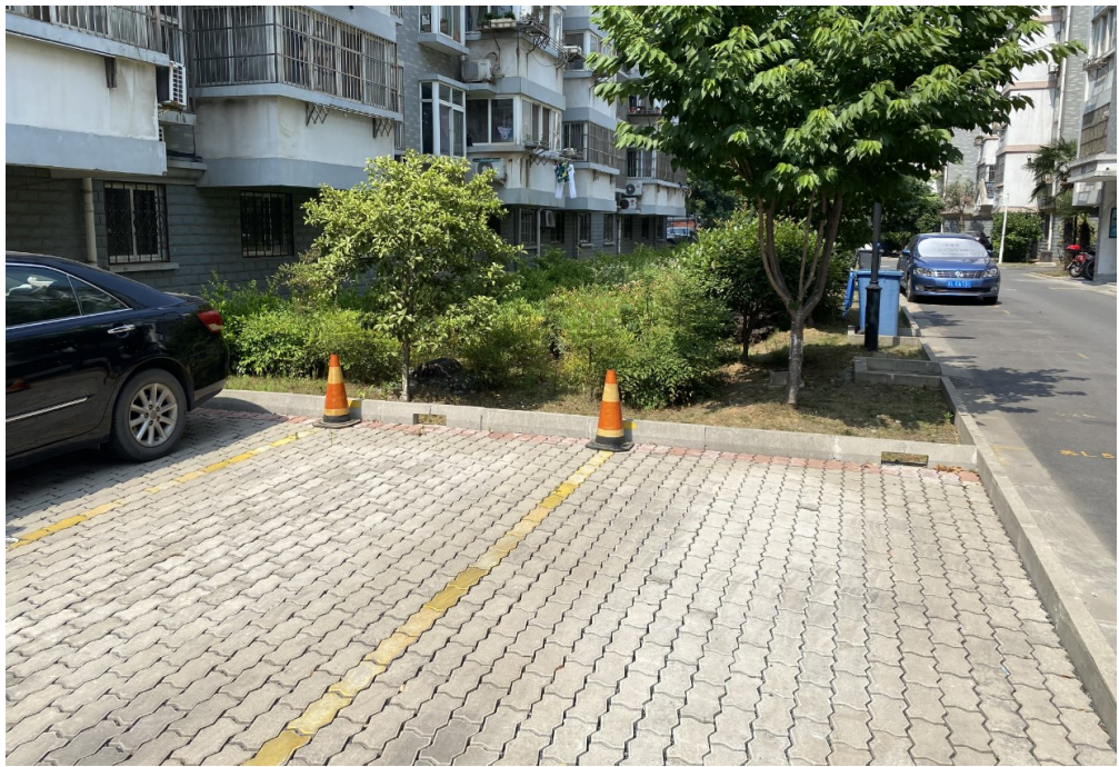
图 7 缝隙式透水停车位
