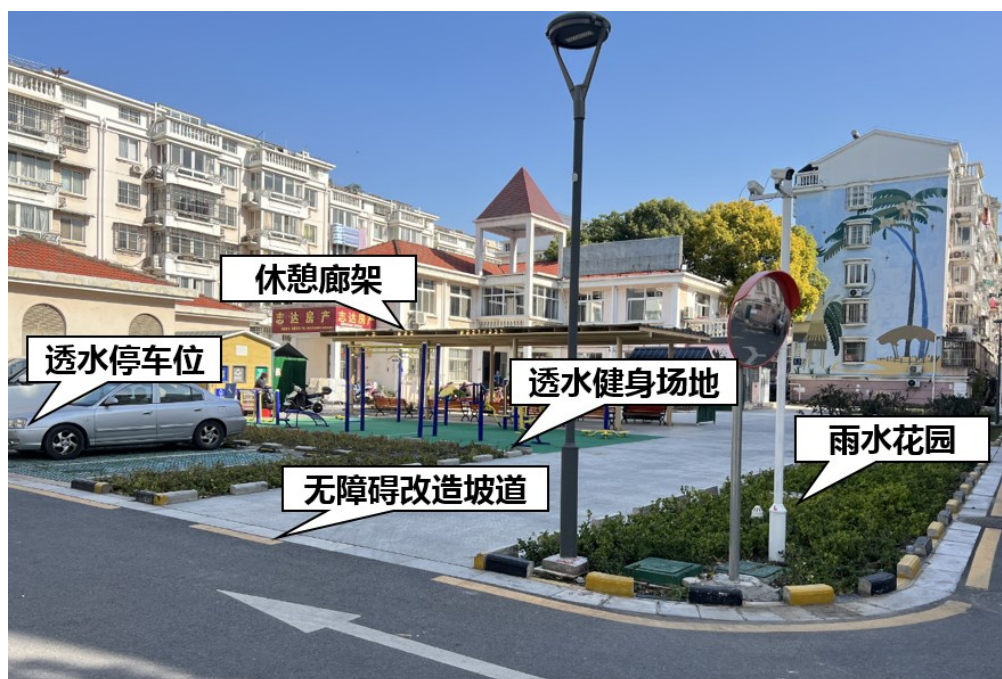
图 33 公共广场适老化改造“+海绵”改造后
