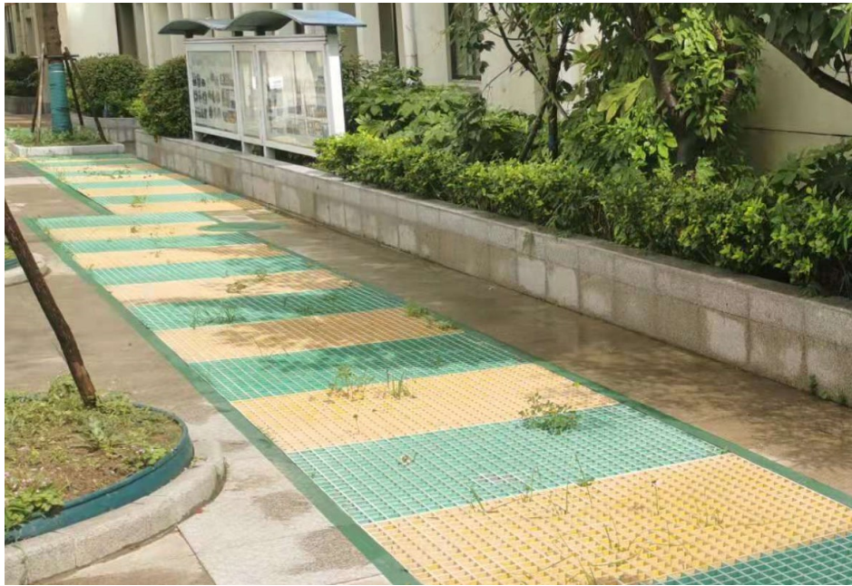
图 5 格栅式生物滞留设施（结合铺装设置）
