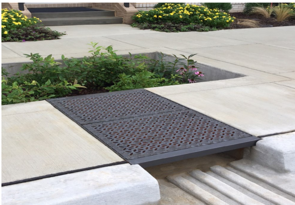
图 26 开口路缘石（结合人行道开槽）
