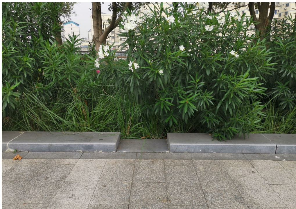
图 21 开口路缘石（直接开口）
