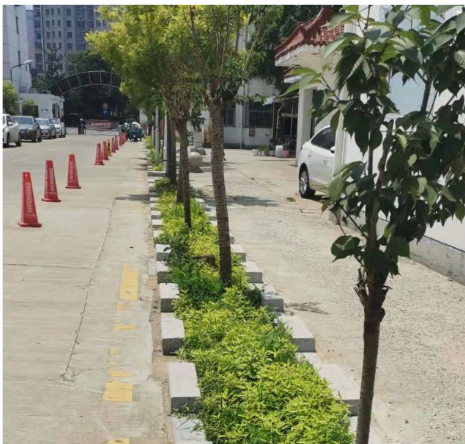
图3 直壁式生物滞留带
