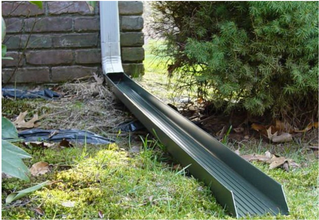
图 18 雨落管断接+导流槽
