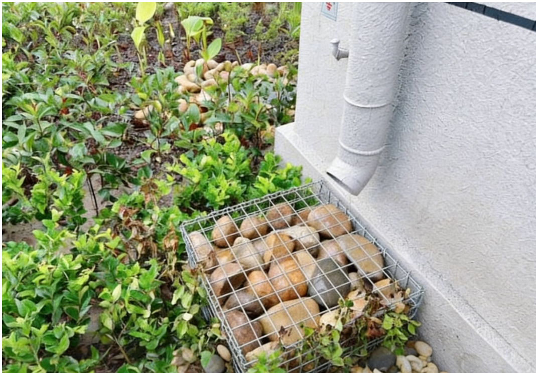
图 19 雨落管断接+石笼
