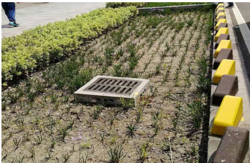
图 25 开口路缘石（侧向砌筑块石）
