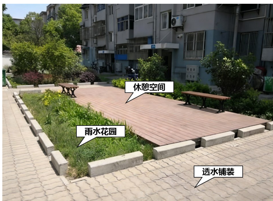
图 37 宅前公共休憩空间打造“+海绵”改造后
