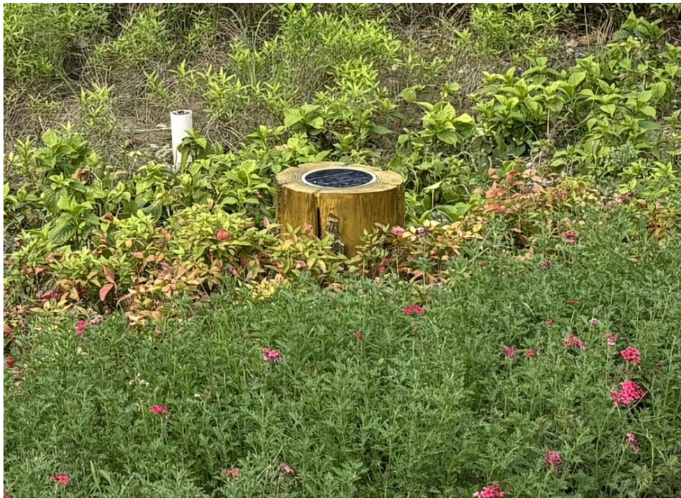
图 31 溢流检查井（结合景观小品设置）
