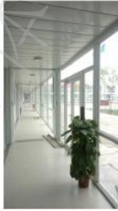
图 2：单排外走廊封闭
