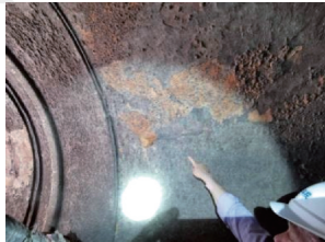
PCCP管道内部情况照片
