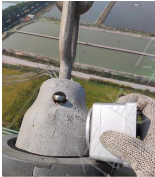
图 B.3 现场测量照片
