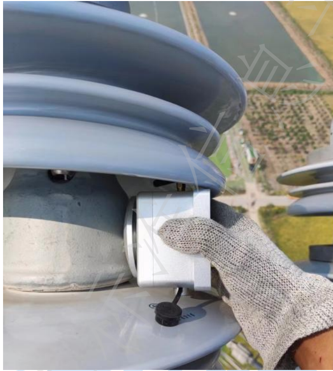
图 B.1 现场测量照片
