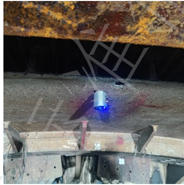
图 4 护盾尾部传感器安装示例
