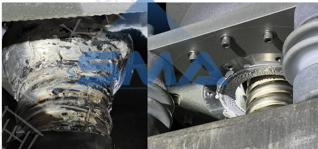
图 D.3 某 220kV 电缆终端消缺照片
