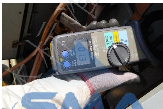
图 C.4 不停电换位装置主要操作步骤：确认感应电流正常
