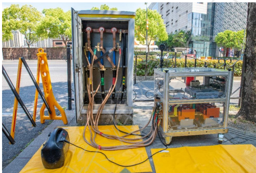
图 C.1 不停电换位装置主要操作步骤：接入连接夹具
