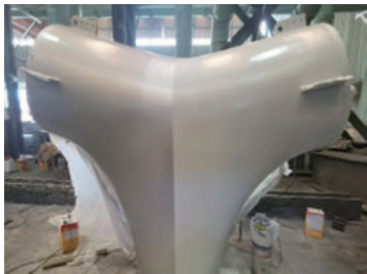
图 4 双组分环氧膨胀型防火体系
