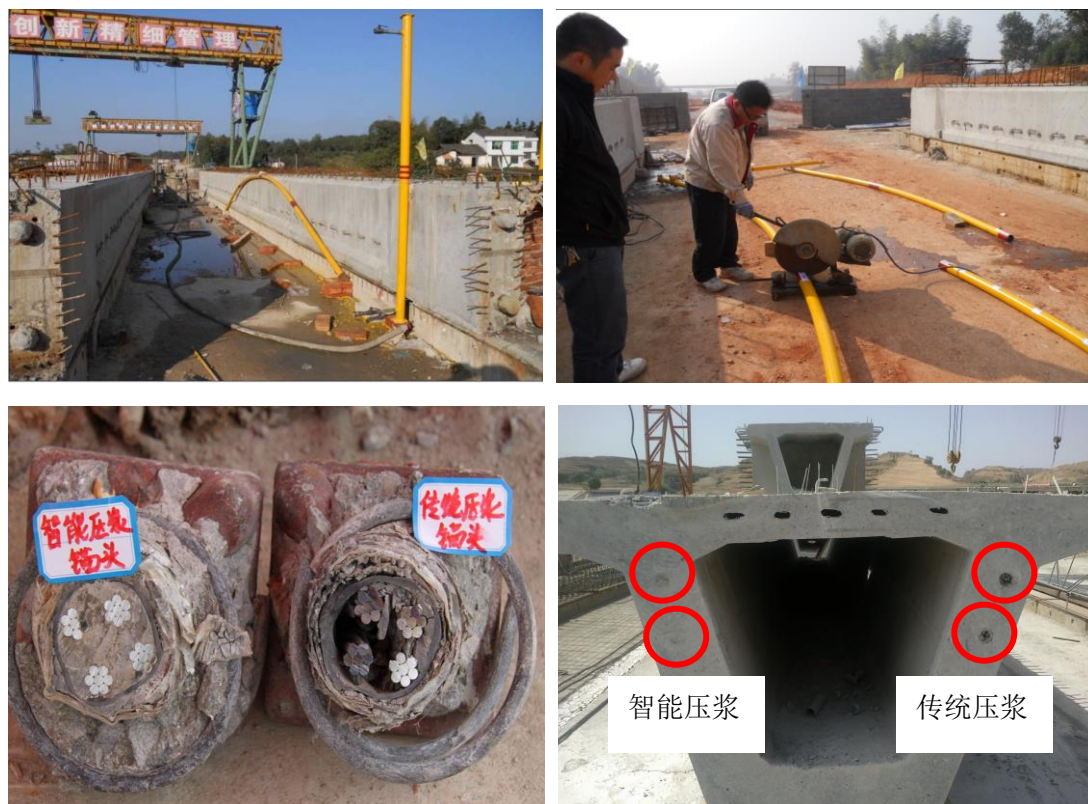
说明图8.3.4.5 现场工程实体压浆试验切片对比照片
