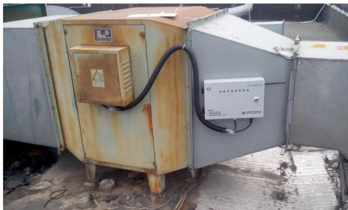
图 1 油烟在线监控现场图片
