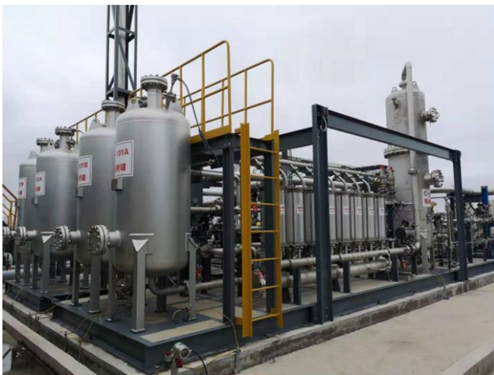
图 5.3 膜分离耦合装置（吸收+膜+吸附）回收有机废气撬块
